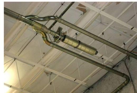
Система удаления композитной пыли:
