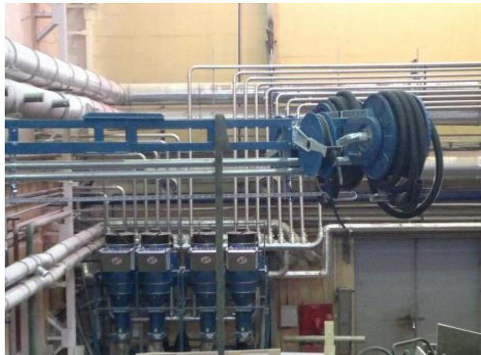
Слева – взрывобезопасные фильтры, справа – система высоковакуумных труб
